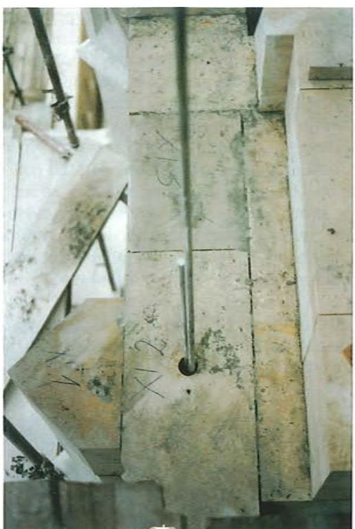
Slika 12. Nastavljanje vertikalnih sidara
