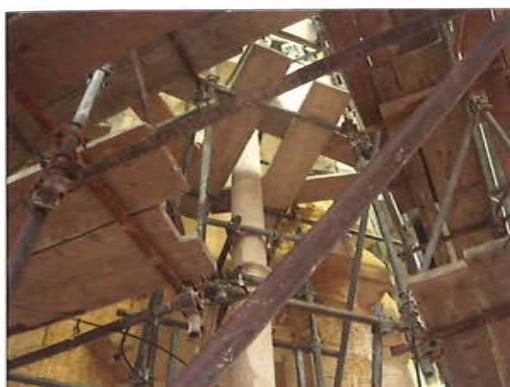
Vitki uglovni stup s druge galerije ide u središte baldahina podno treće galerije. Dok nema baldahina, stup je učvršćen cijevima i mosnicama.
