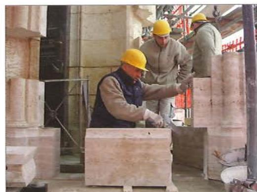
Jugoistočni kut druge galerije bio je posebno zahtjevan. Tamo je trebalo ponovno sazidati zidove unutarnjeg stepeništa tornja i osposobiti stepenište. Većim dijelom korišten je dobar, uređen stari demontirani kamen, a oštećeni dijelovi zamijenjeni su novim kamenom.
